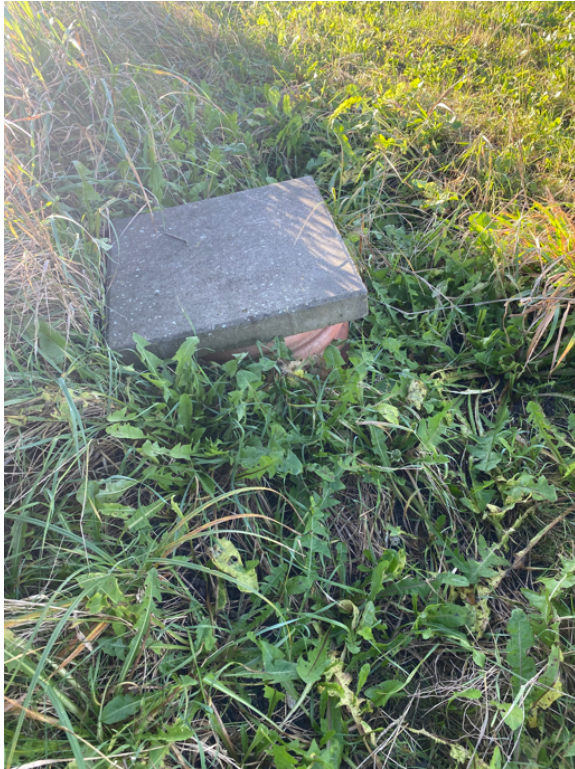
Figur 27: Lokaliseret brønd langs markvej.
