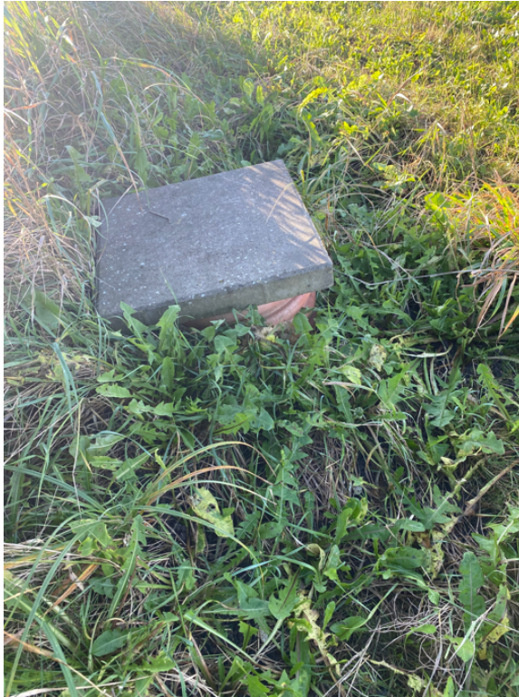
Figur 27: Lokaliseret brønd langs markvej.
